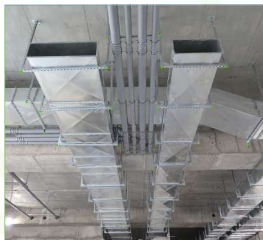
نمونه اجراشده سیستم‌های ساپورت مدولار لینکران
